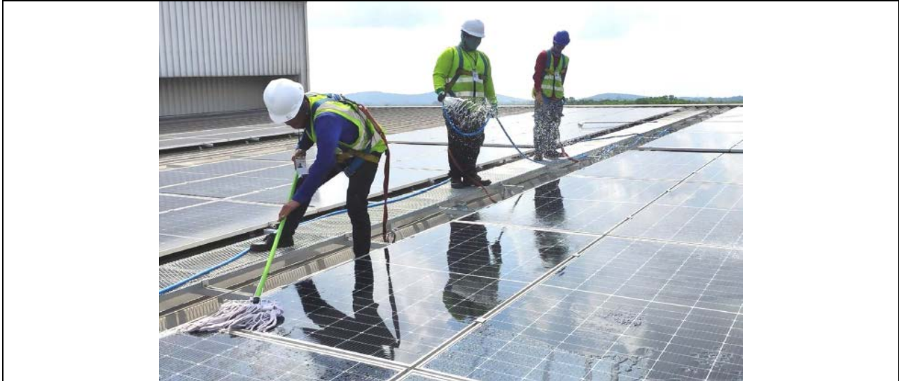
รูปที่ 2.5-4 ภาพตัวอย่างการทำความสะอาดแผงเซลล์แสงอาทิตย์บนหลังคา
